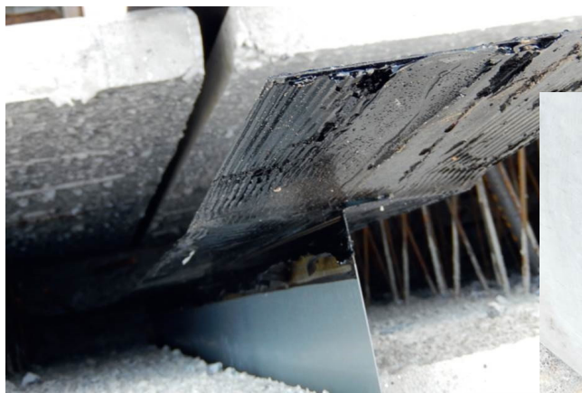
Quelle: Hohmann der Bausachverständige
