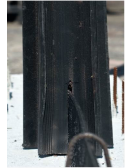
Quelle: Hohmann der Bausachverständige
