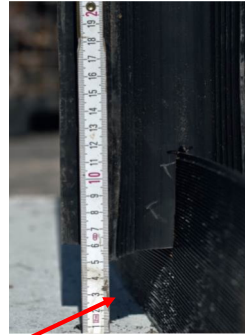
Quelle: Hohmann der Bausachverständige
